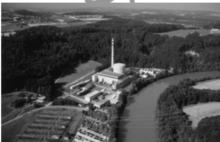
Centrale nucléaire de Mühleberg
